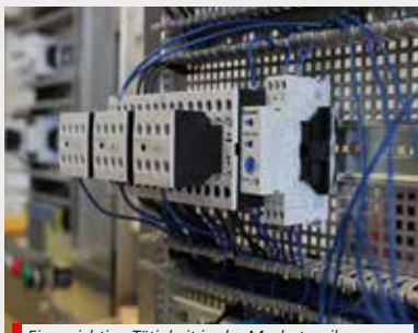
Eine wichtige Tätigkeit in der Mechatronik: Der Anschluss von Steuerungskomponenten
