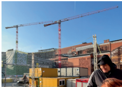
Blick auf den Neubau für das Staatstheater Nürnberg im Zentrum des Kolosseums
